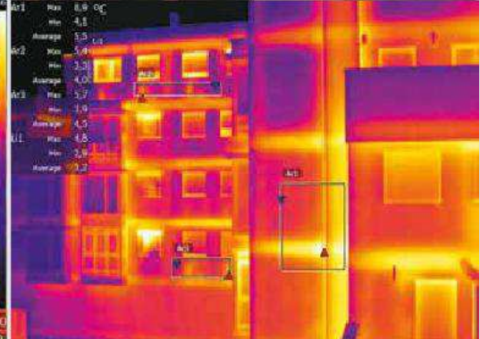
Detalle de la fachada que da a la zona de jardín
