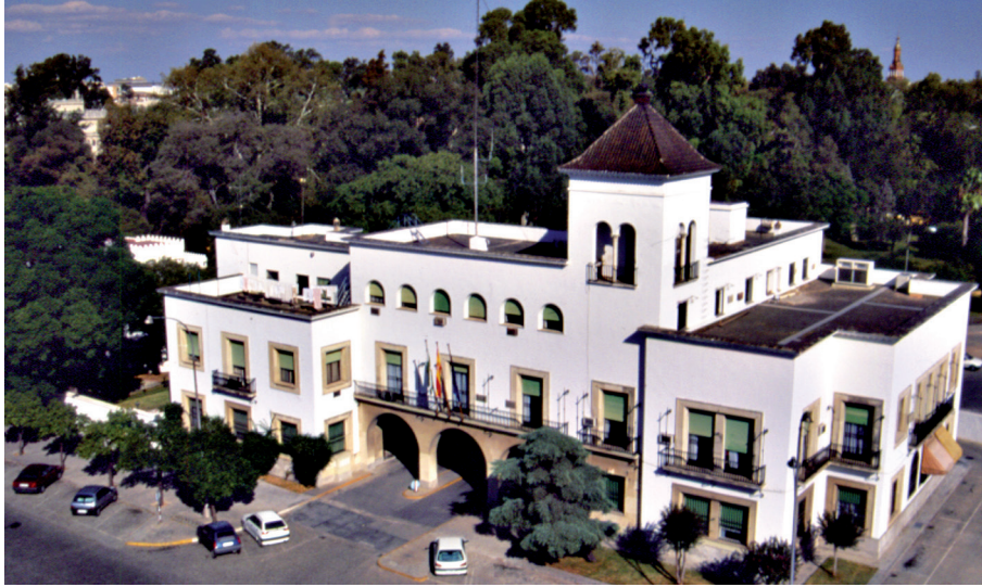
Figura nº 18. Edificio sede de la Autoridad Portuaria de Sevilla. s/f (década de 1990). Archivo de la Autoridad Portuaria de Sevilla.
