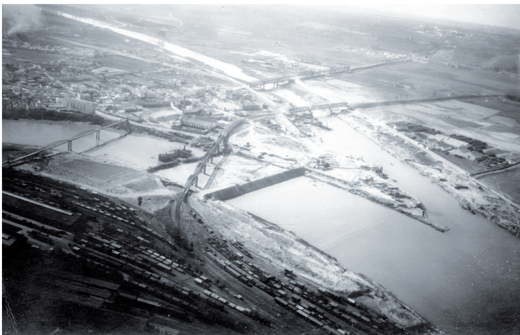
Figura nº 7. Vista aérea con las obras del tapón de Chapina y corta de la vega de Triana. Año 1949. Archivo de la Autoridad Portuaria de Sevilla.
