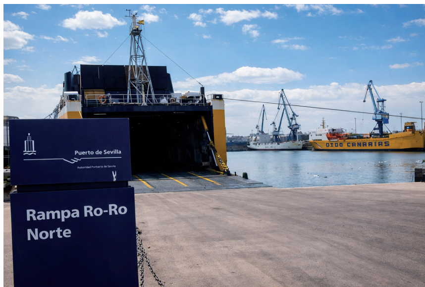
Figura n° 20. Rampa Ro-Ro Norte, dársena del Batán. s/f (década de 1990). Archivo de la Autoridad Portuaria de Sevilla (imagen mejorada con IA).
