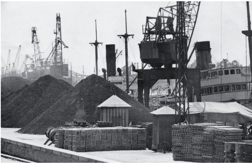
Figura nº 9. Movimiento de graneles en el muelle de Las Delicias. s/f (década de 1940). Archivo de la Autoridad Portuaria de Sevilla.
