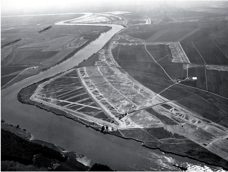
Figura nº 12. Vista aérea con las obras de excavación, en primer plano, de la corta de La Isleta y, al fondo, Los Olivillos. s/f (década de 1970). Archivo de la Autoridad Portuaria de Sevilla.
