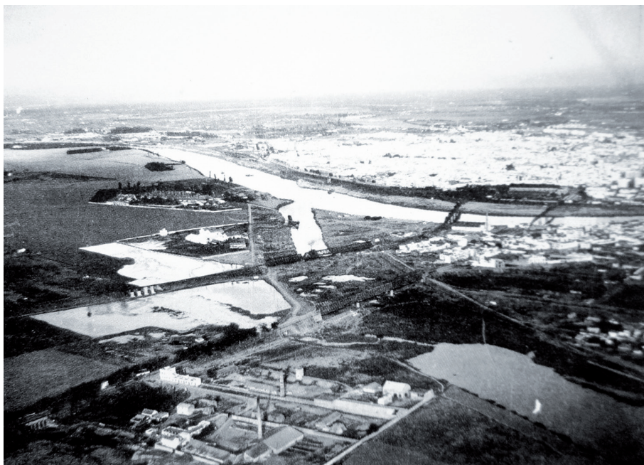
Figura nº 4. Obras de excavación de la corta de la vega de Triana, a la altura de la capilla del Patrocinio. s/f (década de 1940). Archivo de la Autoridad Portuaria de Sevilla.
