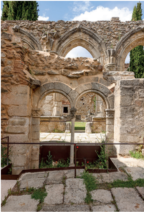
ALZADO INTERIOR DE LA FACHADA DE LA IGLESIA CON LAS INYECCIONES REALIZADAS.
