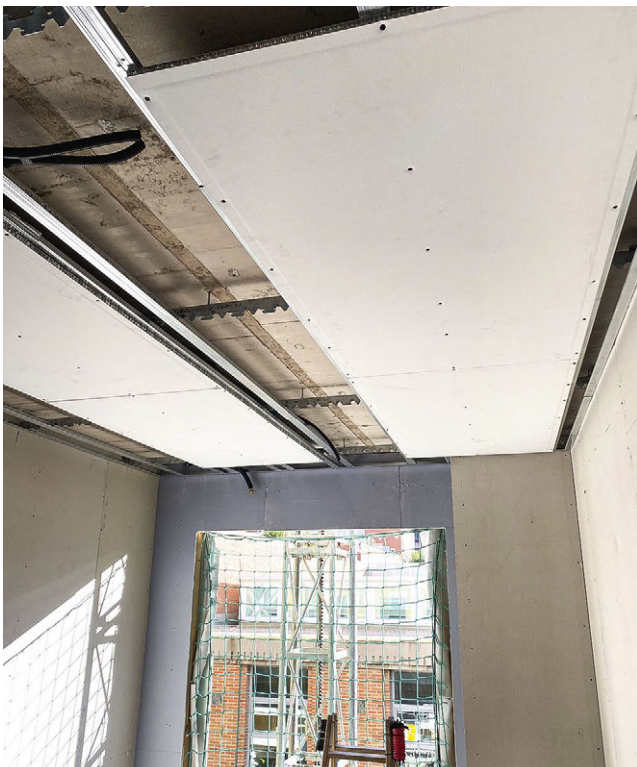
Montaje en techo del panel radiante de baja entalpía Sunthal Dress
