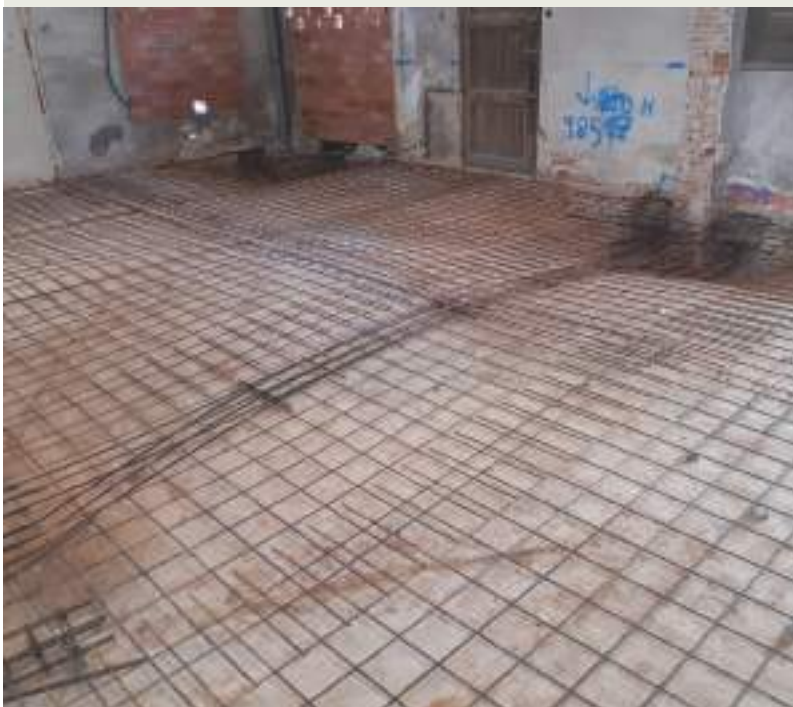
Procés de reforçament de les voltes del soterrani. Fotografia: David Giró.
