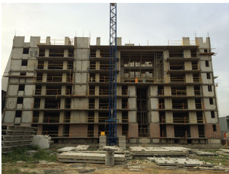
Figura 5. Proceso de montaje de paneles prefabricados desmontables de hormigón armado en SAYAB
