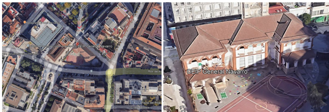
Figura 18. (izq) Localización y (der) vista general Del Colegio General Navarro. Fuente: Google Earth.
