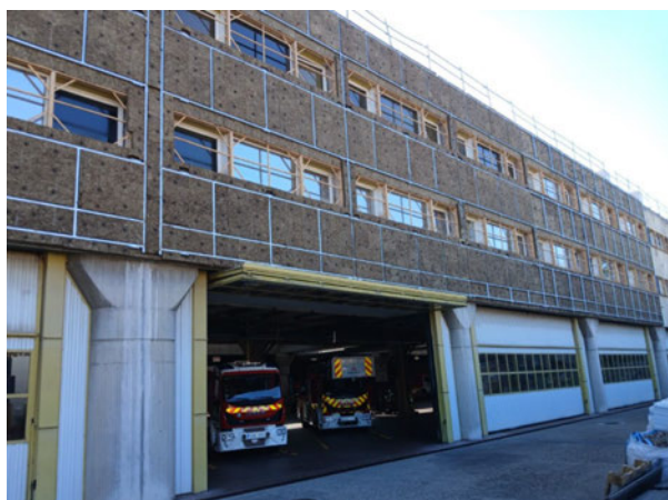
Figura 1. Fachada posterior durante la rehabilitación con las cocheras de bomberos
