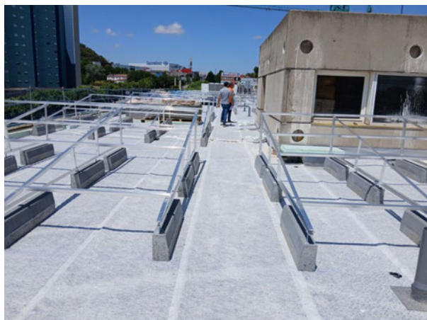
Figura 2. Cubierta con subestructura para paneles fotovoltaicos
