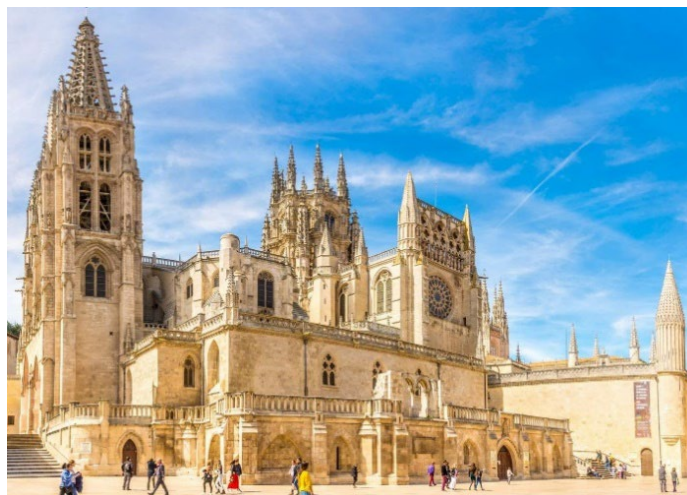
Figura 4. Vista general de la Catedral de Burgos, con la torre sur a la izquierda.
