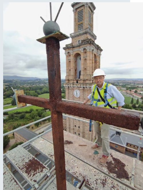
↑ Santiago en el andamiaje sobre la Linterna de la iglesia de La Laboral.
