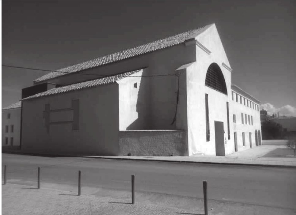
Figura. 3. Vista general del estado rehabilitado. Foto del autor.
