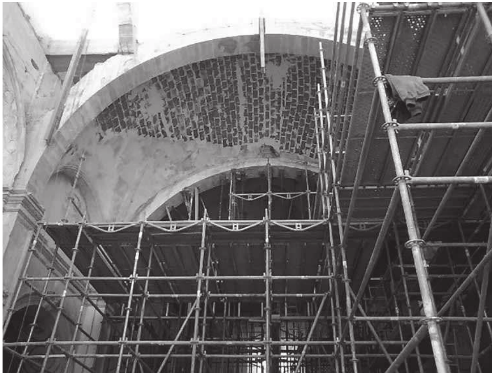
Figura. 6. Reconstrucción de la bóveda vaída de la 3ª crujía. Foto del autor.
