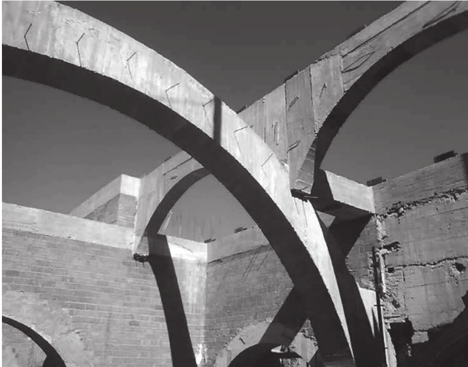
Figura. 4. Vista parcial del nuevo sistema de arcos de hormigón armado. Foto del autor.
