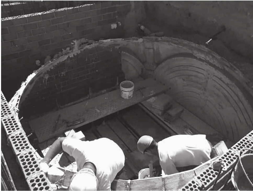
Figura. 5. Tabicado de la bóveda vaída de la 3ª capilla Oeste. Foto del autor.
