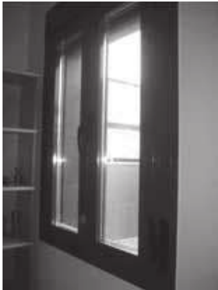
Figura 2. Vista de la ventana por el interior.
