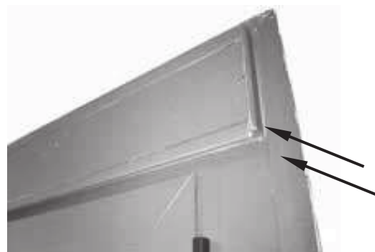
Figura 9. Sellado de la junta del cajón-ventana.
