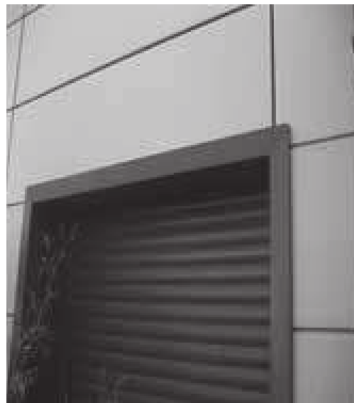
Figura 3. Vista de la ventana y recercado por el exterior.
