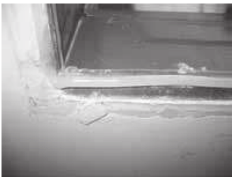
Figura 8. Sellado perimetral por el interior.
