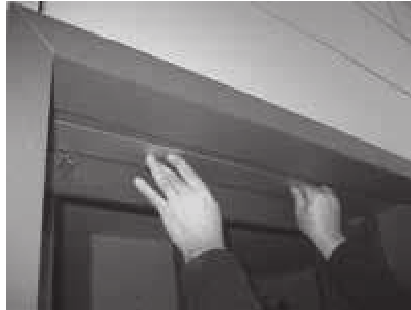
Figura 7. Colocación de tapajuntas.
