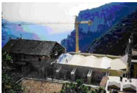
ABANS I DESPRÉS DE LES OBRES DE RECONSTRUCCIÓ DE LA COBERTA (1994). S'APRECIEN ELS CONTRAFORTS, ÒCULS I CIMBORIS RESCATATS
