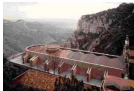
ABANS I DESPRÉS DE LES OBRES DE RECONSTRUCCIÓ DE LA COBERTA (1994). S'APRECIEN ELS CONTRAFORTS, ÒCULS I CIMBORIS RESCATATS
