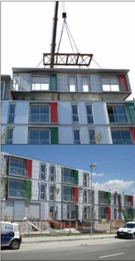
MUNTATGE DELS MÒDULS DE L'EDIFICI D'HABITATGES DE TORELLÓ DE TAC ARQUITECTES
