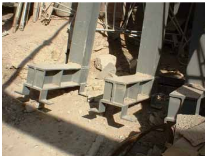
BASE PILAR EN MÈNSULA PREPARADA A TALLER
