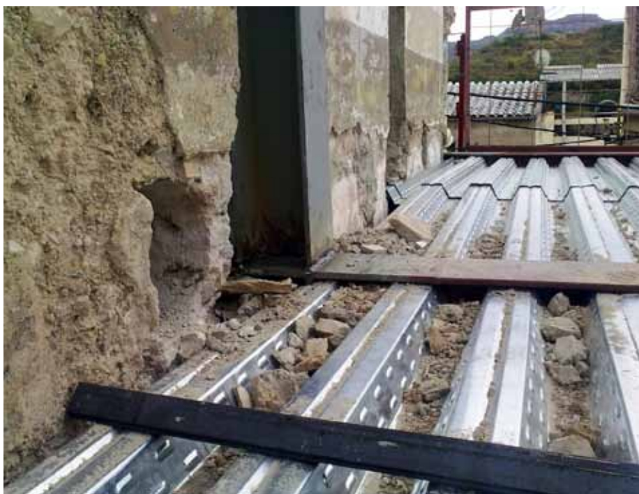
ESTRUCTURA: PILAR ENCASTAT A PARET DE TÀPIA
