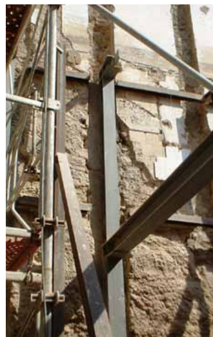
RASES VERTICALS. PILAR ENCASTA A MUR DE TÀPIA. ESTINTOLAMENT PROVISIONAL
