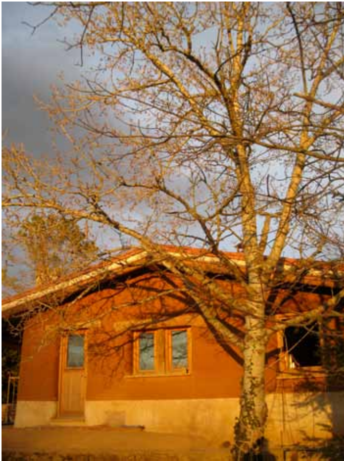
CASA D'AUTOCONSTRUCCIÓ ASSISTIDA AMB COB (MASSES ARRODONIDES DE TERRA), GENTILESA D'ORIOL BALLIU
