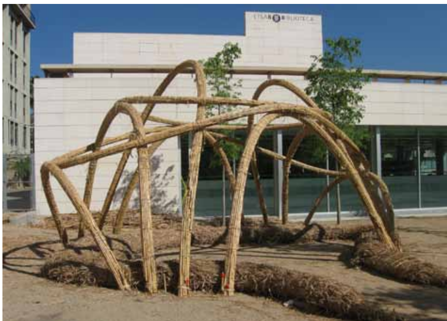
HI HA MATERIALS QUE PERMETEN CONSTRUIR ENTRAMATS RESISTENTS QUE FUNCIONEN COM A ARMADURA ESTRUCTURAL EN ELEMENTS VERTICALS
