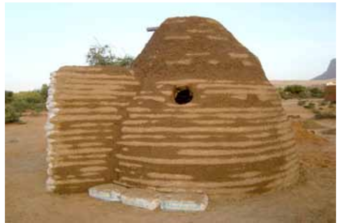
TÈCNICA DE CONSTRUCCIÓ AMB SUPERADOB. PROJECTE "REINVENTER LA MAISON". CC ONG
