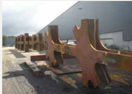
S'OBSERVEN ELS PILARS JA ACOBLATS. S'OBSERVEN COM LES XAPES DE LA FOTOGRAFIA ANTERIOR JA S'HAN SOLDAT CONTRA ELS PERFILS HEB-400 O IPE-400, SEGONS EL CAS, PER CONFORMAR ELS NUSOS, I AQUESTS AL SEU TORN S'UNEIXEN ALS PILARS
