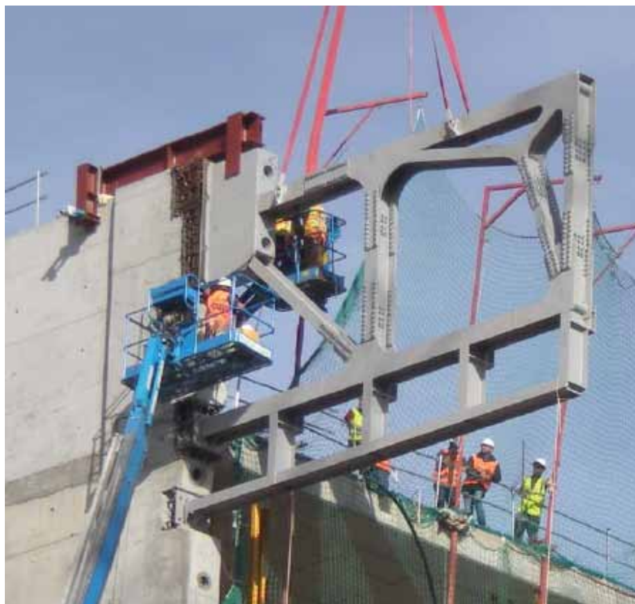
FOTOGRAFIA DEL MUNTATGE EN OBRA DEL MÒDUL SUPERIOR DEL VOLADÍS POSTERIOR DE 8 M DE LONGITUD
