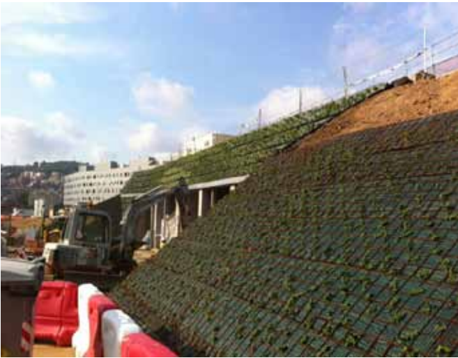
MUR DE TERRES ARENADES (AV. DE L'ESTATUT DE CATALUNYA)
