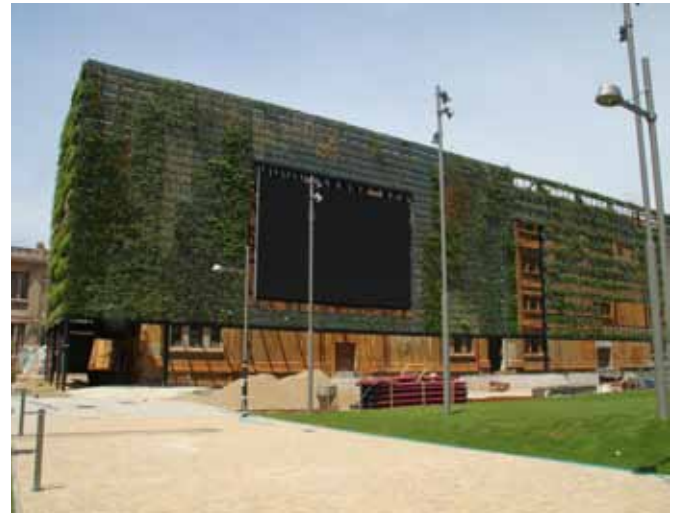
SISTEMA BABYLON A L'EDIFICI DE LA TABACALERA DE TARRAGONA
