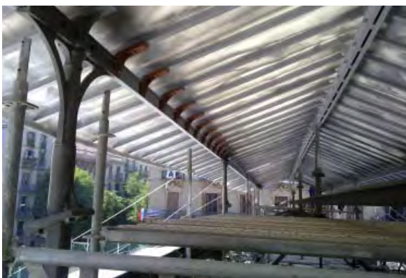
INTERVENCIÓ A LES LLUERNES
