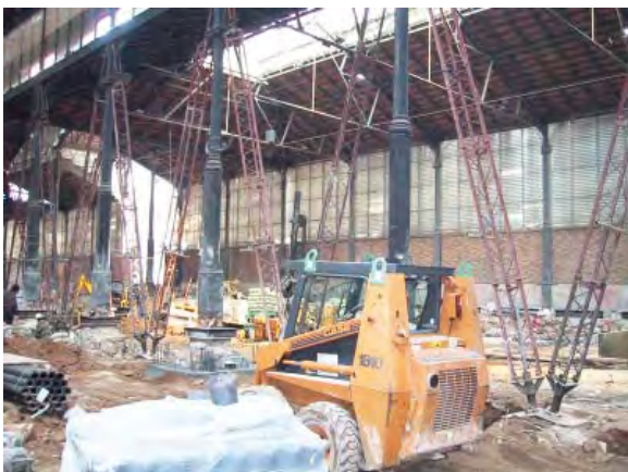
ESTINTOLAMENT DELS PILARS
