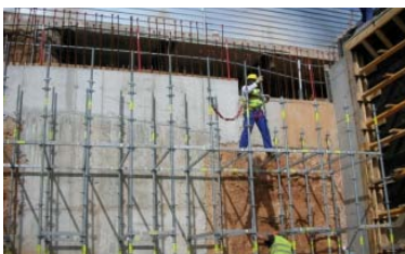
UN MOMENT DE LES OBRES AL DHUB A LA PLAÇA DE LES GLÒRIES
