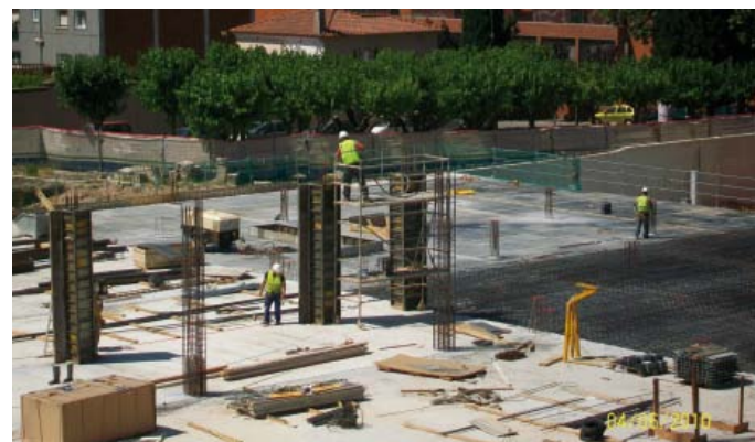
OBRES AL POLIESPORTIU LES MORERES D'ESPLUGUES DE LLOBREGAT ©: SGS TECNOS
