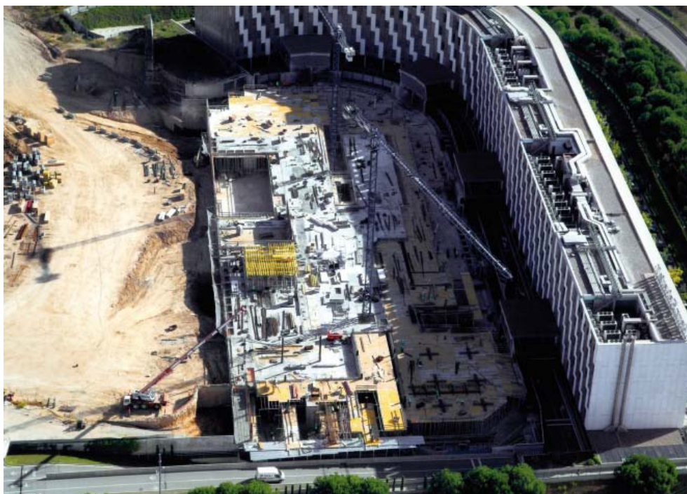
VISTA GENERAL DE LES OBRES A LA NOVA SEU DEL BANC SABADELL DE SANT CUGAT DEL VALLÈS.
