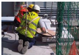
OBRES A LA SEU CORPORATIVA D'MRW ©: ORIGENS, GESTIÓ I DIRECCIÓ D'OBRES
